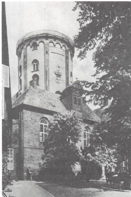
Regensgården efter ombygningen 1906-08, med Regenslinden fra 1785 samt træerne foran kirkefløjen fra 1803. Foto fra 1920'erne.
