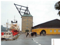
Mastekranen klar til besigtigelse
